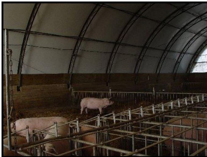
Estructura tipo túnel con cama profunda, Universidad de Minnesota (Morris). Fuente: Marlene Halverson
